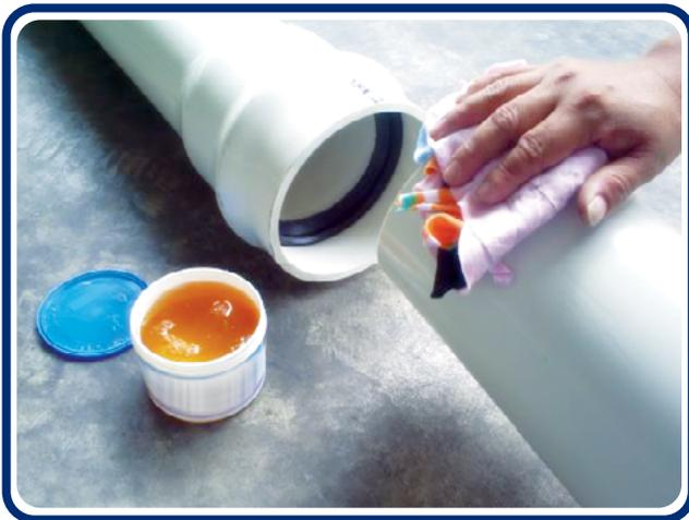
4. Aplique lubricante TUBOSA en el interior de la campana y espigo y; acople la tubería.
